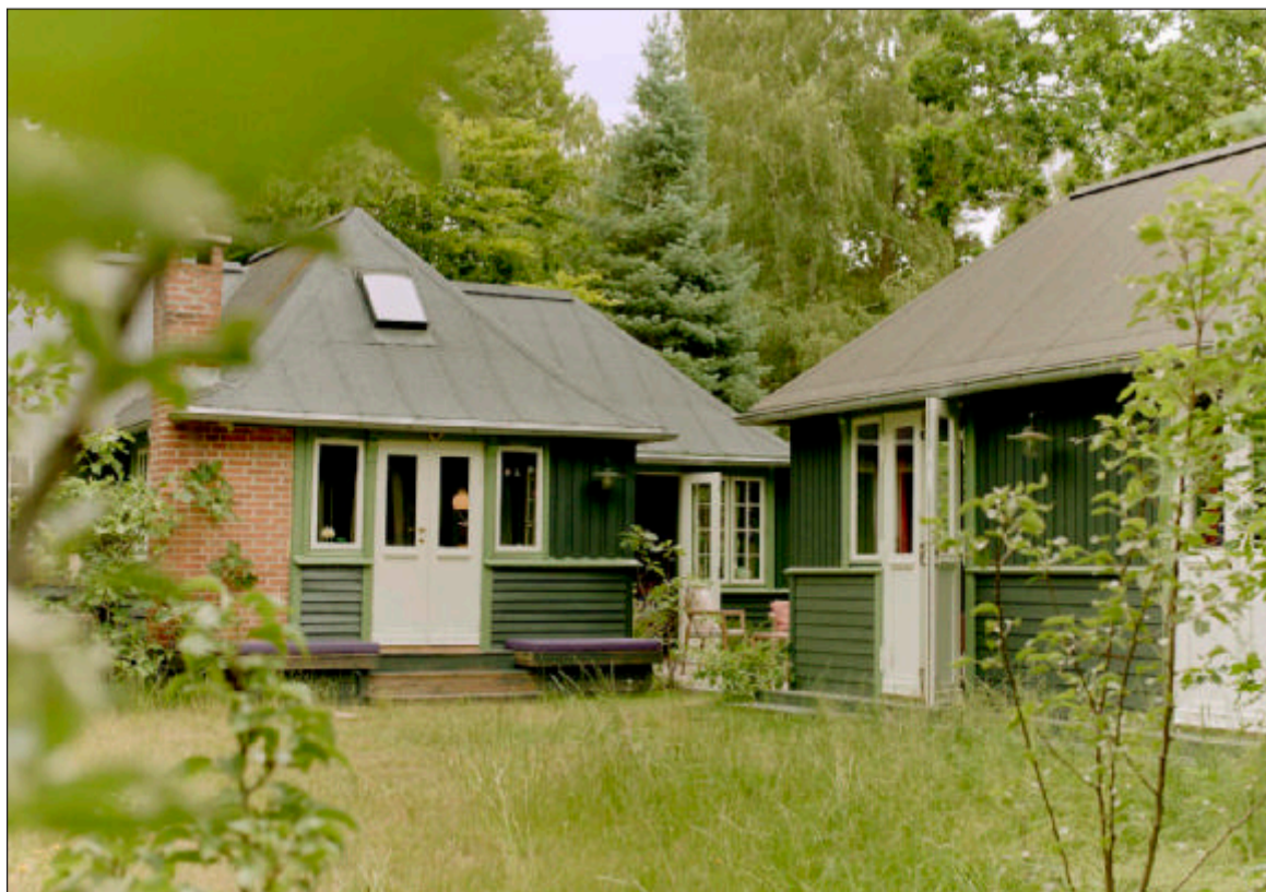
Huset set fra haven med annekset til venstre og den nye køkkentilbygning, som Adam Schnack og Nadia Olive Schnack fik opført i 2020 – som den seneste del af husrenoveringen.
